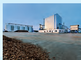
Das Biomasse-Heizkraftwerk Wittgenstein erzeugt pro Jahr etwa 100.000 Megawattstunden Nutzwärme und 38.000 Megawattstunden Strom.
